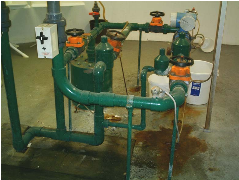
Entnahmestelle über dem Bohrloch vor Ableitung in die Behandlungsanlage
